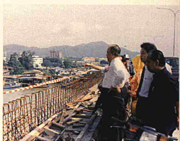
JAMBATAN TANJUNG LUMPUR ... meninjau jambatan yang sedang dalam pembinaan.
